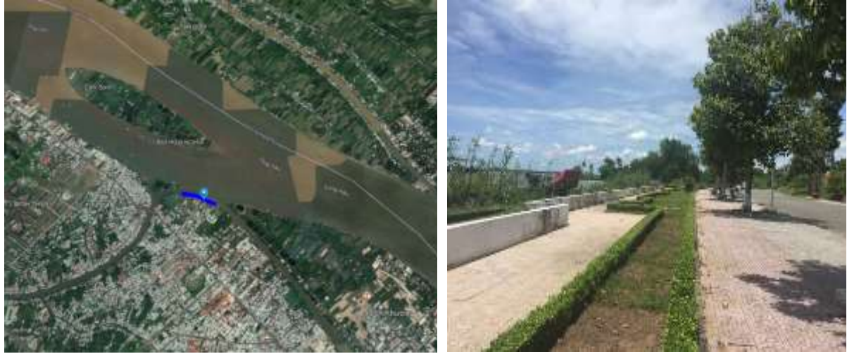
Hình 3-21. Kè bảo vệ bờ khu dân cư An Thới, quận Bình Thủy
