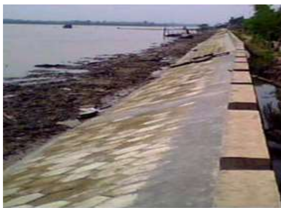
Hình 3-11. Kè lát mái bằng tấm BT chân phủ rọ đá-xã An Hóa, sông Giao Hòa
