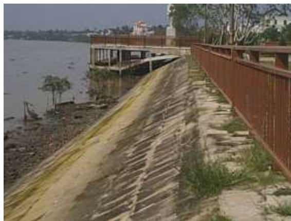
Hình 3-10. Kè lát mái bằng tấm bê tông - Kè bảo vệ bờ Bắc sông Bến Tre
