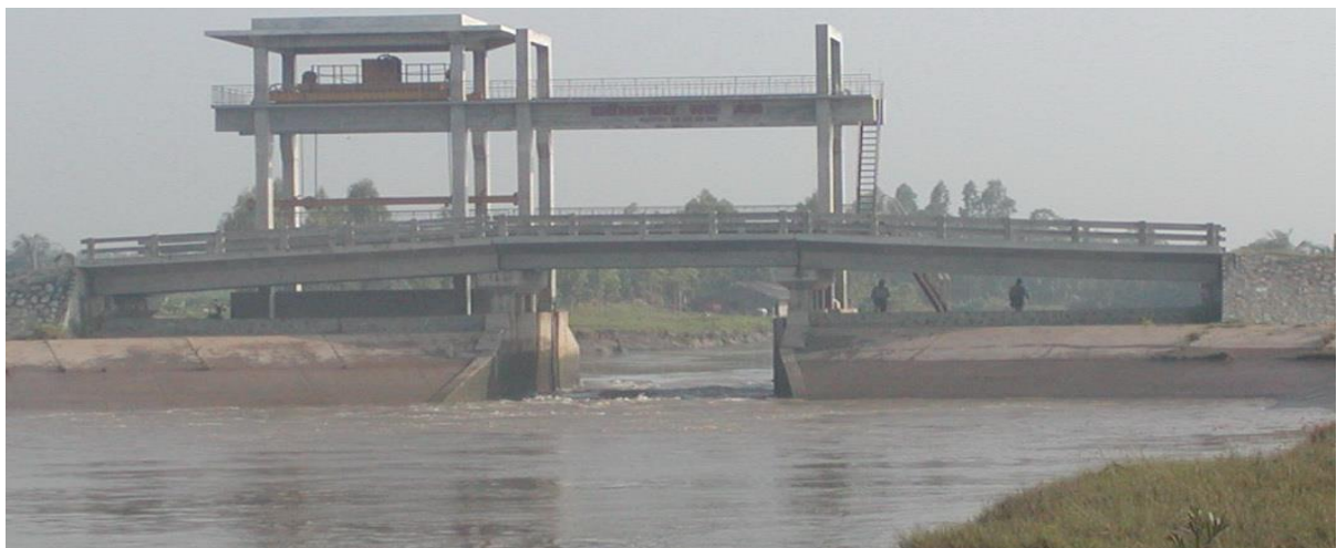
Hình 6: Hiện trạng công hở DBSCL (chưa mở thêm khoang công)
