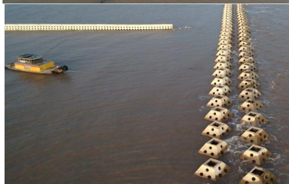
Hình 6: Quá trình vận chuyển và thi công để giảm sóng kết cấu rỗng TC1, TC2 tại bờ biển Cồn Cống-Tiền Giang
