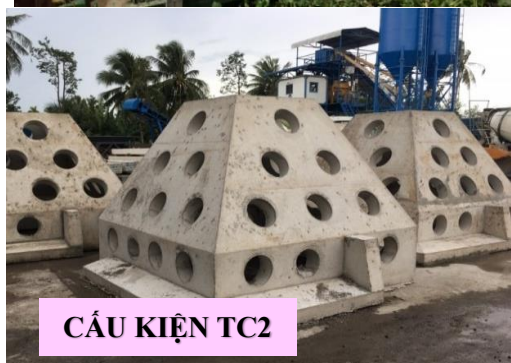
Hình 6: Quá trình vận chuyển và thi công để giảm sóng kết cấu rỗng TC1, TC2 tại bờ biển Cồn Cống-Tiền Giang
