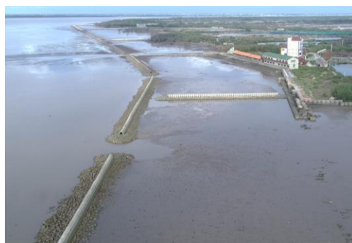
Hình 7: Tuyến công trình bảo vệ bờ biển Cồn Cống hoàn thiện tháng 12/2019 (trái) và bãi bồi tháng 05/2020 (phải)
