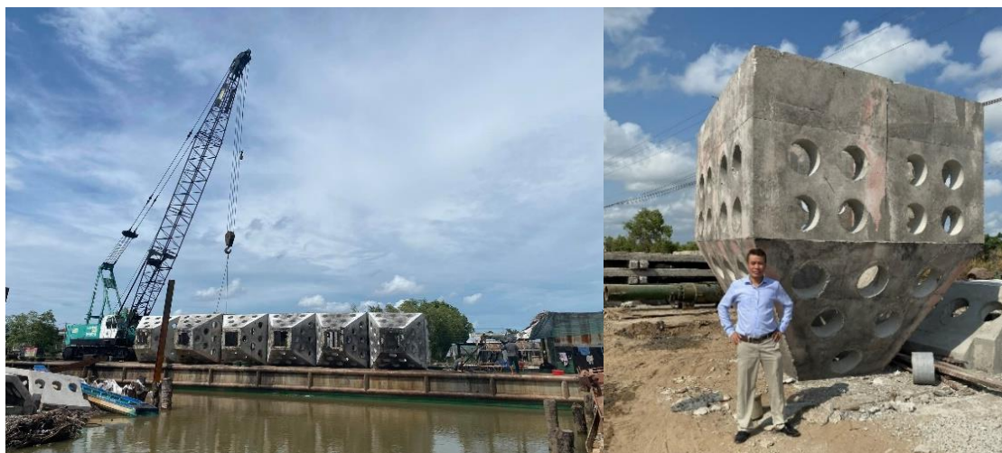
Hình 9: Công tác đúc cấu kiện TC2 chuẩn bị thi công (5/2021)
