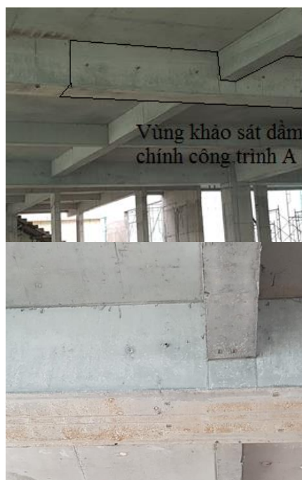
Hình 4: Khảo sát công trình A Đầm không xuất hiện vết nứt
