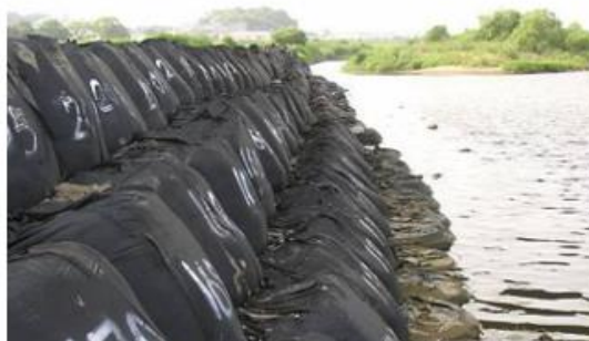
Hình 1: Một số hình ảnh chống sạt lở bãi bằng túi địa kỹ thuật kích thước lớn (2T) [6]
