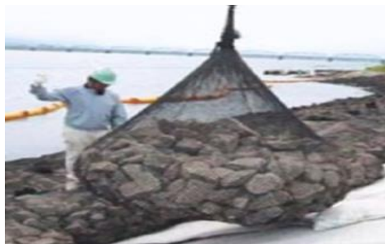
Hình 2: Hình ảnh sử dụng rọ đá Polyester ngoài thực tế [9]
