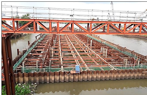
Hình 6. Mô phỏng giải pháp xây dựng cống trên lòng dẫn tự nhiên bằng giải pháp đóng cừ thép Larsen tạo khung vây hồ móng khô cho hạng mục công trình
