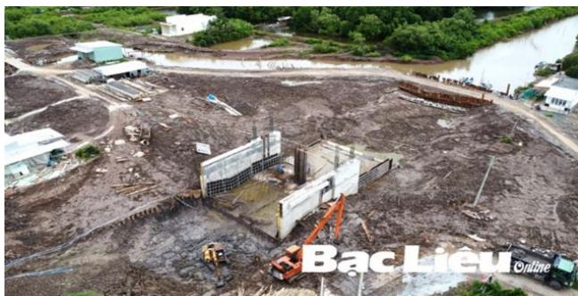
Hình 5. Mô phỏng giải pháp xây dựng cống trên lòng dẫn tự nhiên bằng giải pháp đắp đập tạm, bơm cạn nước hồ móng công trình
