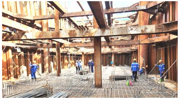
Hình 6. Mô phỏng giải pháp xây dựng cống trên lòng dẫn tự nhiên bằng giải pháp đóng cừ thép Larsen tạo khung vây hồ móng khô cho hạng mục công trình
