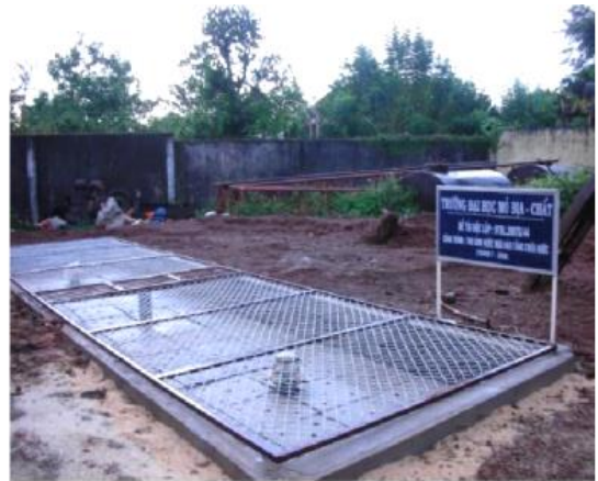
Hình 3. Mô hình thu nước mưa để bổ cập nhân tạo ở Tây Nguyên
