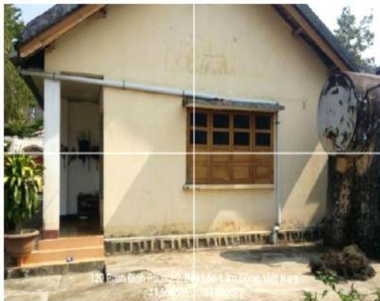
Hình 3. Mô hình thu nước mưa để bổ cập nhân tạo ở Tây Nguyên
