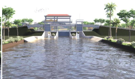
Hình 2. Minh họa cống tự động vùng triều ĐBSCL đã mở thêm 2 khoang cửa van cưỡng bức ở 2 bên mang cống
