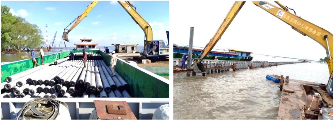
Hình 5. Biện pháp thi công đóng cọc bê tông ly tâm
