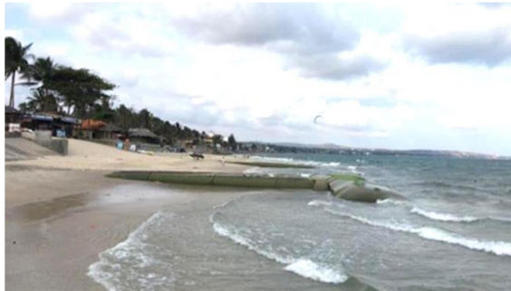
c) Kè mở hàn (T) Geotube KDL Tiến Đạt
