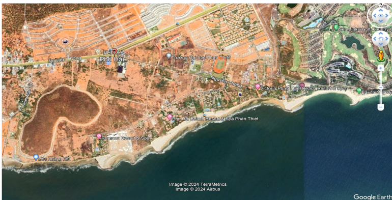
Hình 14. Hình thái đường bờ biển khu vực bãi tắm Romana - Cát Trắng - Phú Hải đang được hình thành các tiểu cung cong sau khi xây dựng các mỏ hàn lấn biển
