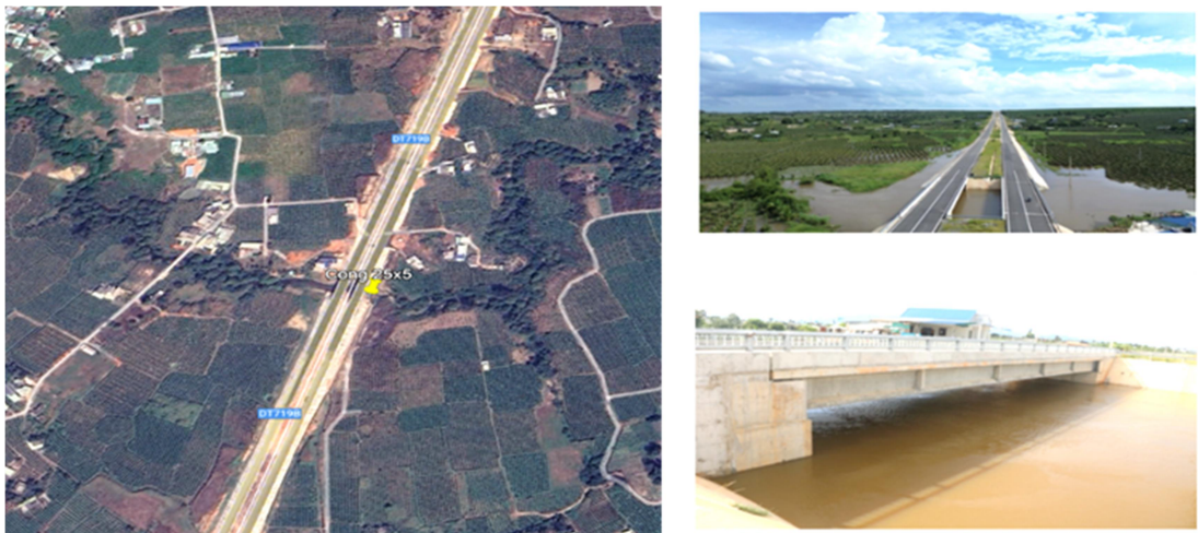
Hình 2. Vị trí cây cầu và cống 25×5 m tại đường tỉnh DT 719B
