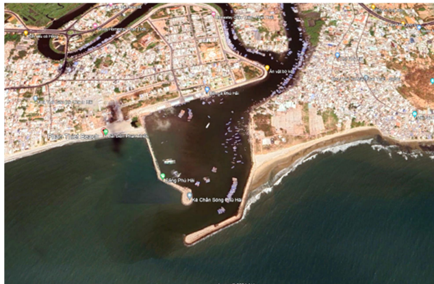
Hình 8. Công trình chỉnh trị cửa sông Phú Hải (nguồn: Google Earth)
