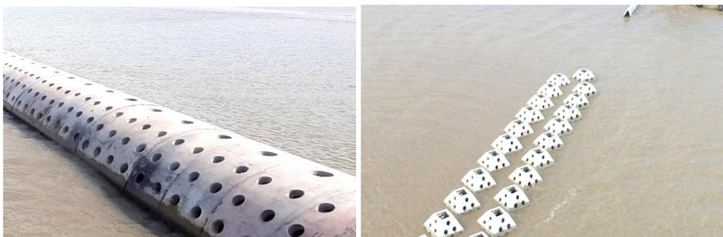
Hình 18. Cấu kiện nối ghép Max 400 có khả năng tháo lắp, di chuyển ứng dụng cho công trình giảm sóng xa bờ
