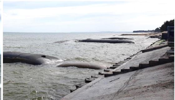
d) Kè mở hàn (I) Geotub KDL Coco
