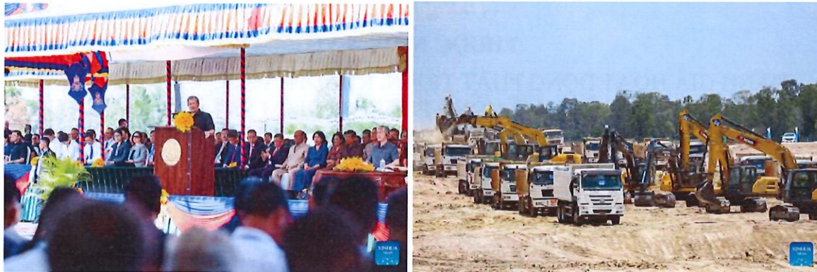
Hình 1: Một số hình ảnh động thổ đoạn 2 dự án Funal Techo, 12/04/2026 (theo Sinhua)
