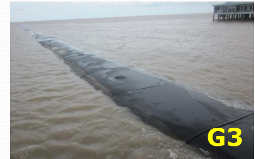
Đê ngầm phá/giảm sóng từ xa bằng ống cát
