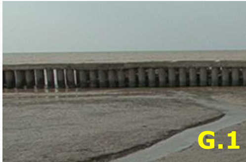
Tường phá/giảm sóng từ xa. BTCT . tuyến thẳng
