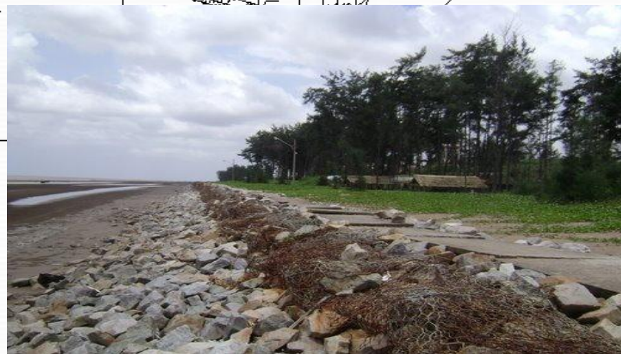
Lưới thép Gabion đoạn kè rọ đá bảo vệ khu du lịch Ba Động
