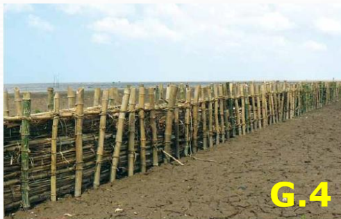
Tường phá/giảm sóng từ xa. bằng cây . tuyến thẳng
