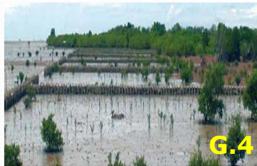
Tường ngầm phá/giảm sóng từ xa + giữ phù sa bằng cây . dạng chữ T
