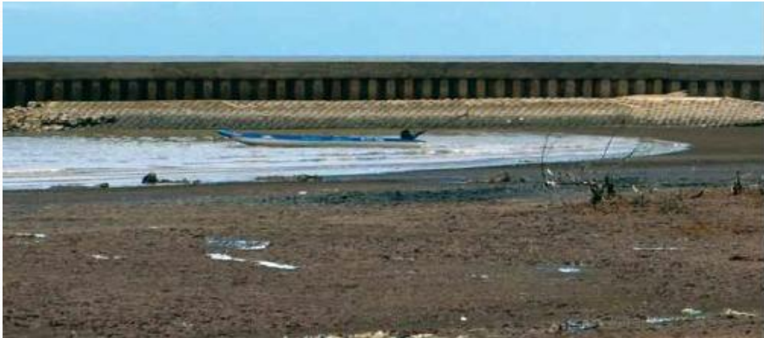
Tường chắn sóng Gành Hào – Bạc Liêu
