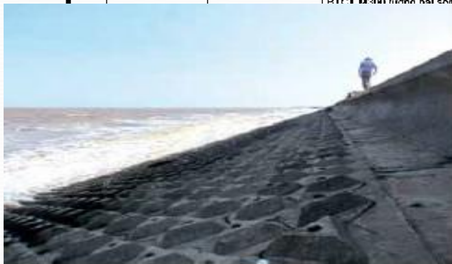
Kè bê tông kết hợp tường chắn thấp bờ biển Trà Vinh
