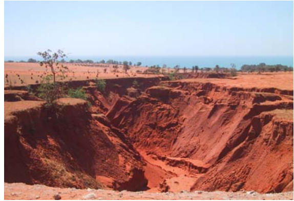
Hình 2: Xói lở đất nghiêm trọng tại xã Hòa Thắng - Bắc Bình - Bình Thuận
