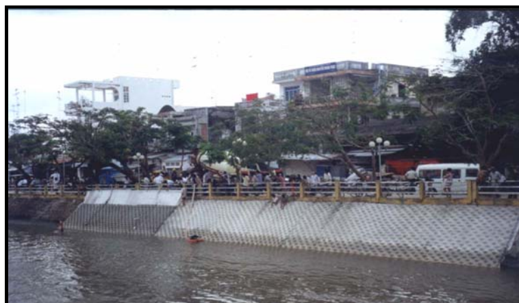
Hình 9: Thảm bê tông bơm trực tiếp trong nước bảo vệ bờ sông khu vực thị xã Rạch Giá tỉnh Kiên Giang
