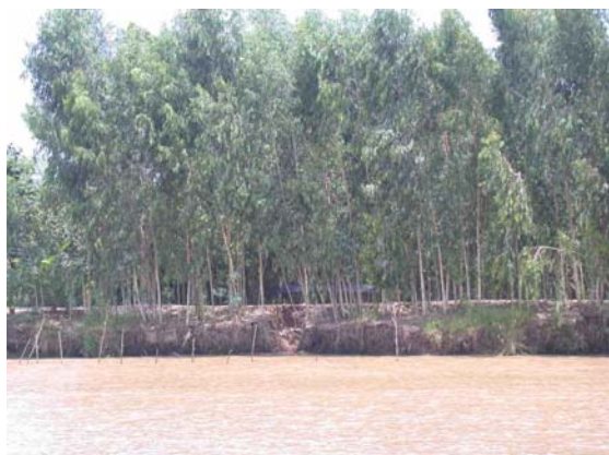
Hình 3: Sạt lở xảy ra hầu hết ở hai bờ kênh 28
