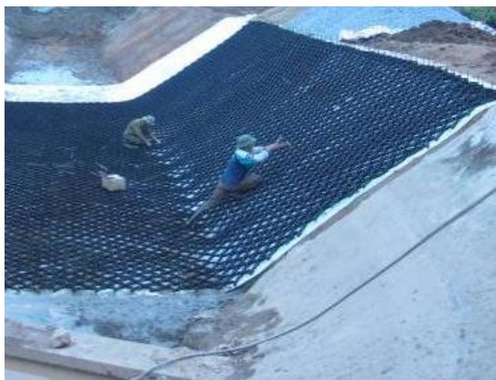
Hình 46. Một số hình ảnh dùng Neoweb gia cố bờ và đáy
