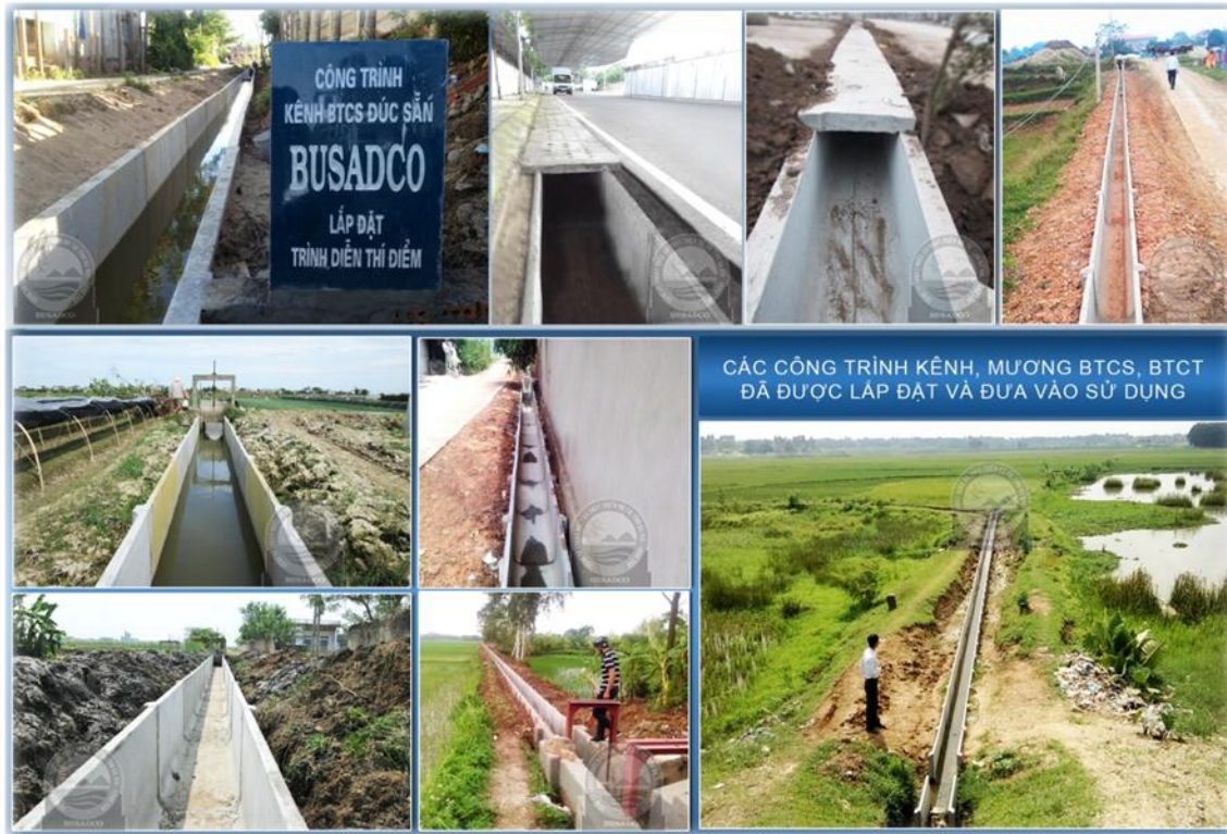
Hình 38. Công nghệ bê tông vỏ mỏng cốt sợi lắp ghép sử dụng để dẫn nước cấp, thoát (công nghệ Busadco)
