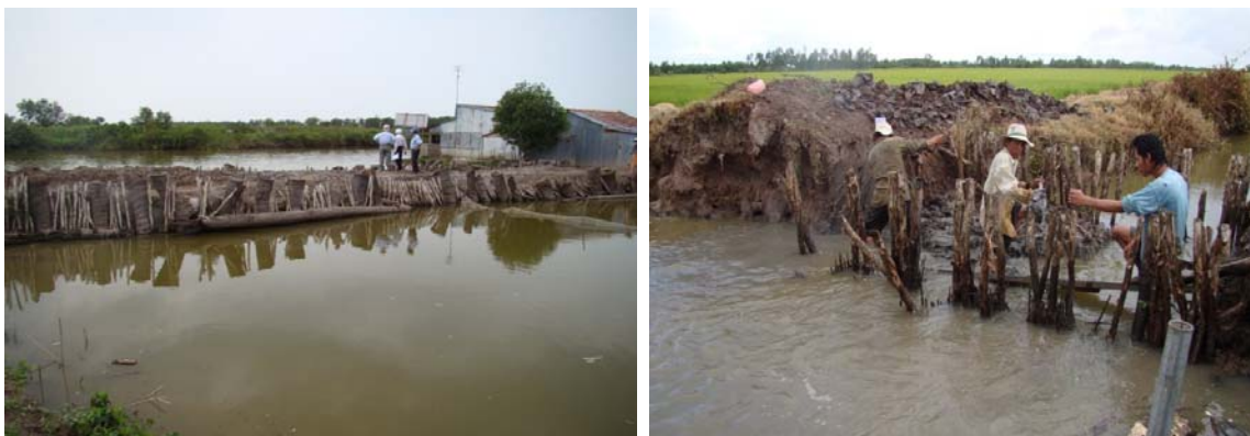
Hình 1: Đập thời vụ bằng đất trong thời gian ngăn mặn và khi phá dỡ
