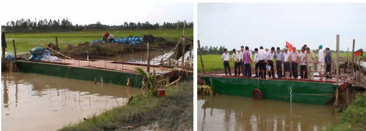
Hình 5: Bàn giao mô hình thực nghiệm đập thời vụ đưa vào vận hành ngăn mặn
